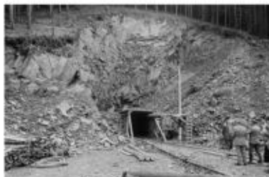
Auffahren des Stollens für die Messkammern im Berg
